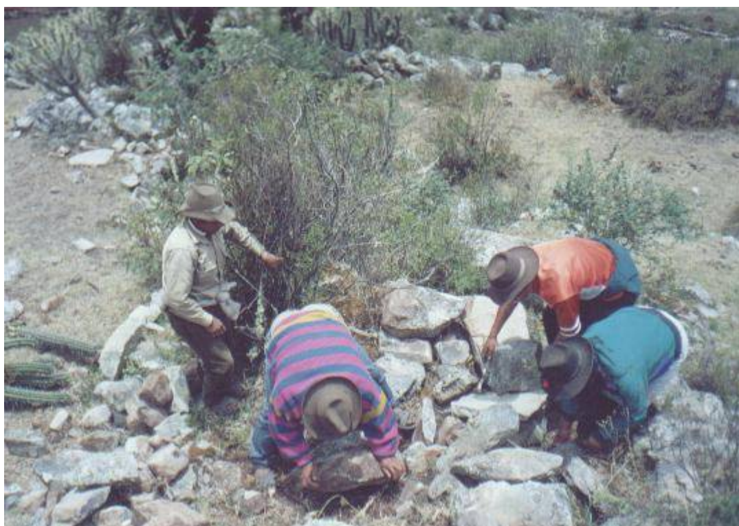
Foto: Construcción de Cercos Comunidad Pallcayño – Microcuenca Pachaconas – Antabamba (foto: IIDA)
