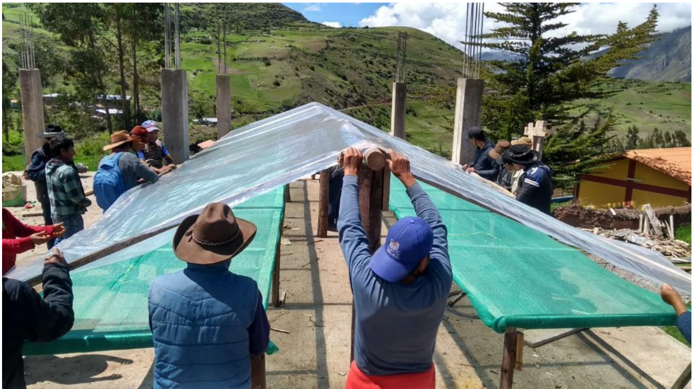
Construcción de secaderos para hongo de pino en Accha
