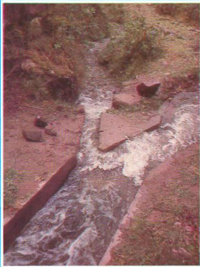
Las estructuras para la distribución del agua entre los sectores, pueden ser de construcción sencilla, aprovechando la topografía del terreno. (Partidor proporcional, Proyecto Sambor, Anta).
