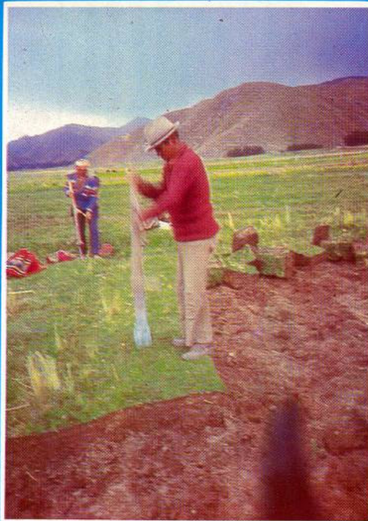
Preparación de terrones de pasto o "champas", para su utilización en el revestimiento de canales y muros de contención. (Encauzamiento río Pomacanchi, Acomayo).
