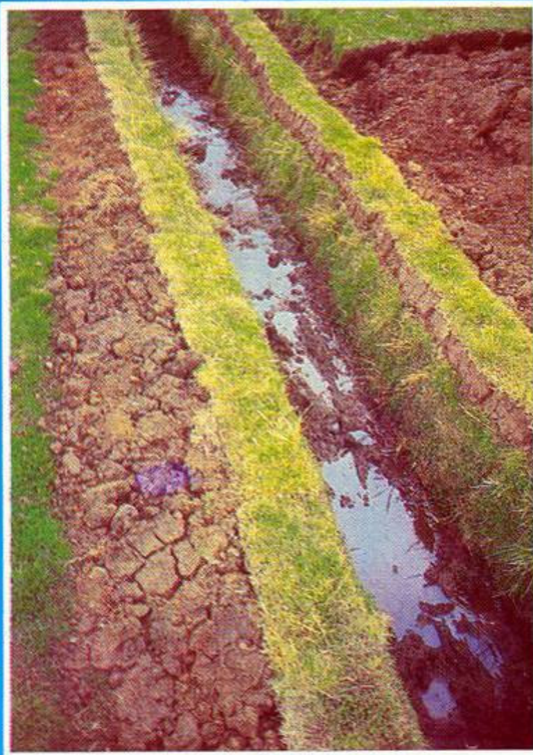
El revestimiento con "champas". Método simple y barato. (Proyecto Quisquisña, Acomayo).
