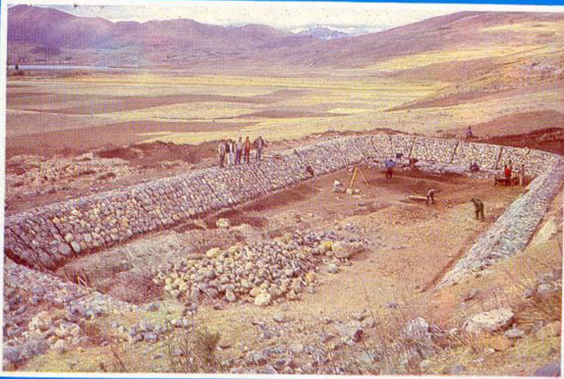
Construcción de un reservorio nocturno. (Proyecto Santo Domingo, Acomayo).
