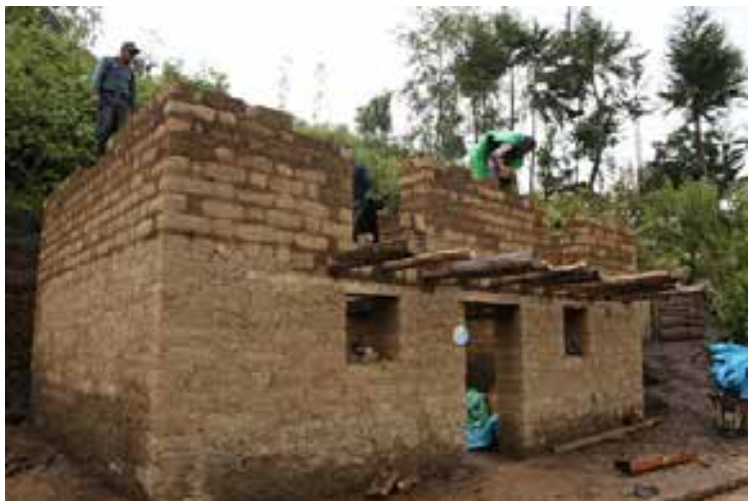
Construcción de casa en Umapata
