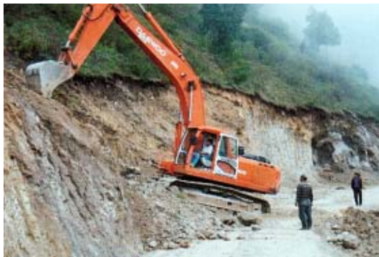
Retroexcavadora recién adquirida por AMUDESC en la apertura de un camino rural
