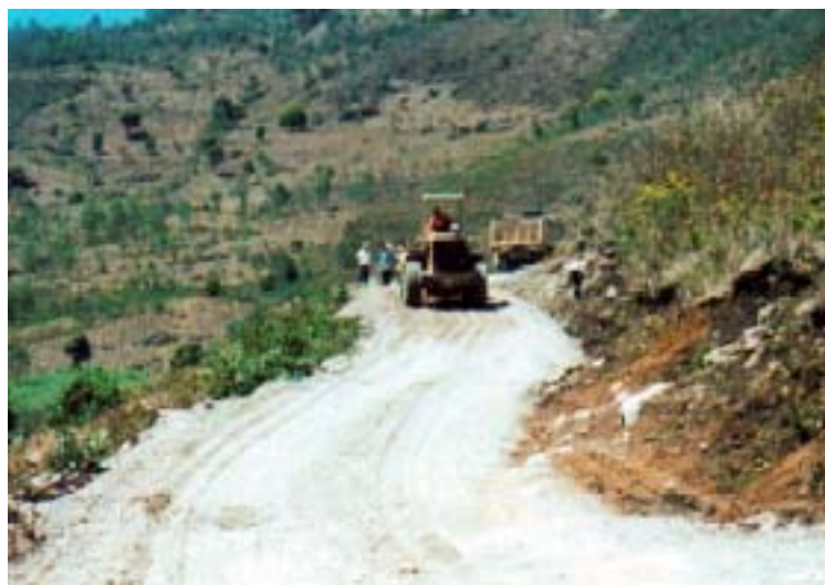
Trabajos de rehabilitación de caminos en la Sierra de los Cuchumatanes
